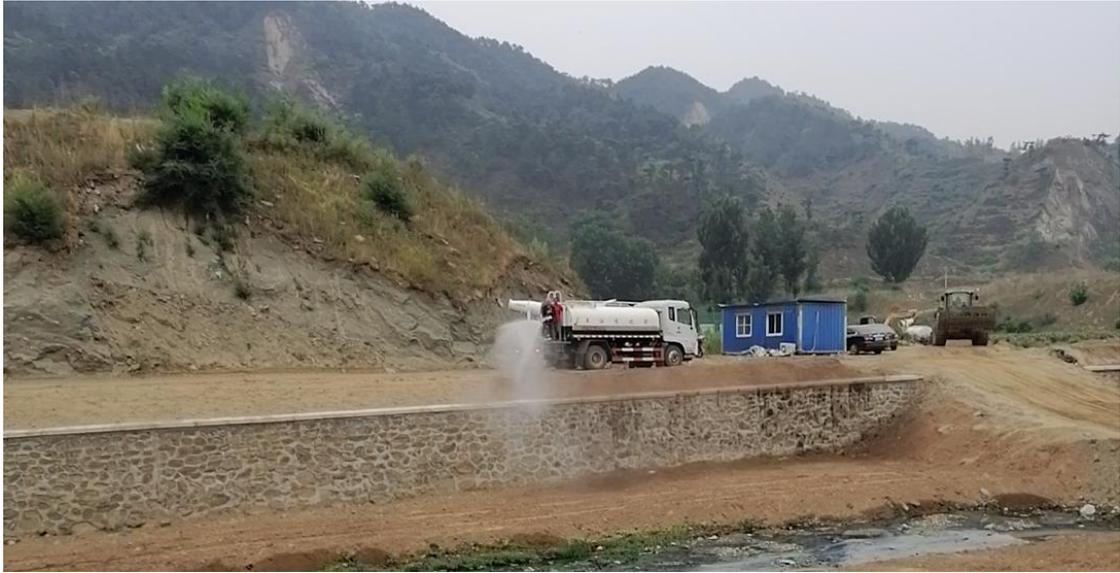
图 4.1-1 洒水车洒水降尘
