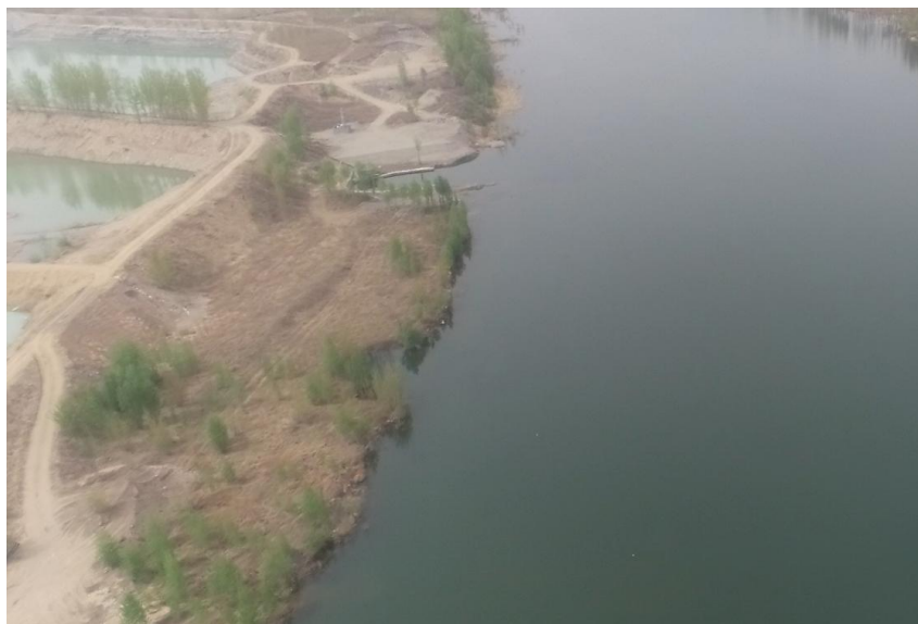
图 3.1-1 现状照片（堤坡无防护、滩地裸露）
