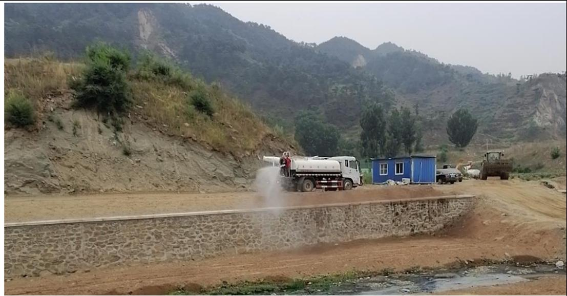
图 4.3 洒水车洒水降尘。
