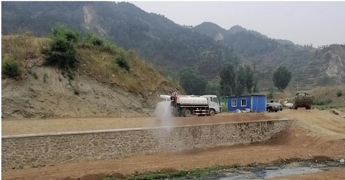
**图 5.2 洒水车洒水降尘**
