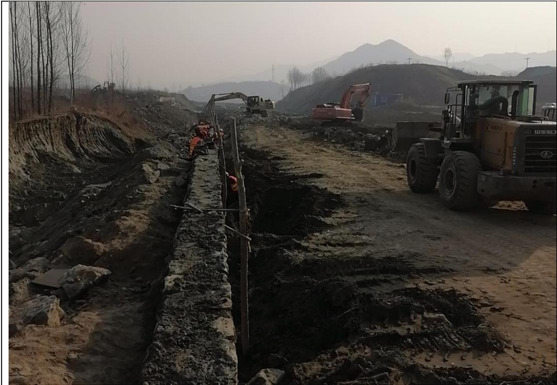
图 2.17 生态护岸施工过程
